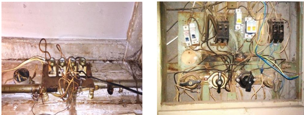
Рисунок 2 – Изношенная электропроводка и оборудование
